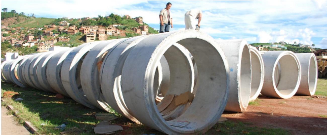
Novos tubos de concreto armado com dois metros de diâmetro irão substituir os antigos
